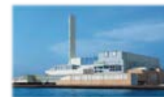
工場の新設・長寿命化工事
